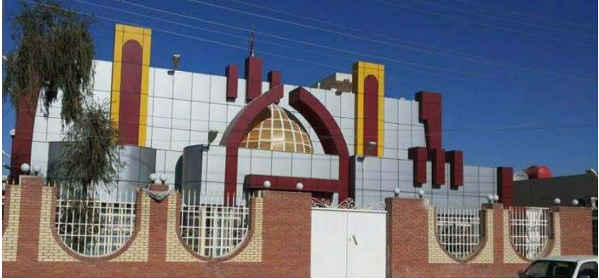
(مجمع اتصالات وبريد ألبدير/ تصميم وإنشاء المكتب الهندسي في وزارة الاتصالات)
